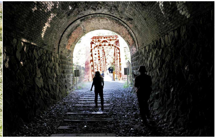
溝滝尾トンネル出口
