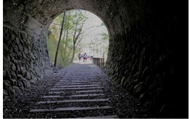
北山第二トンネル出口
