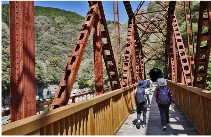
長尾山第一トンネル
