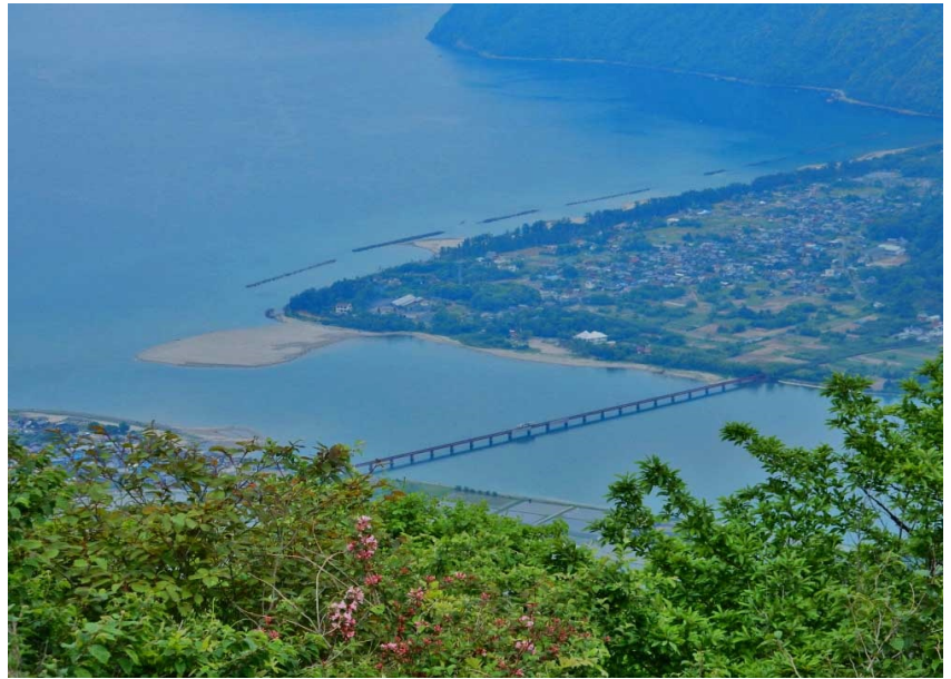
由良川 丹後鉄道 橋梁
