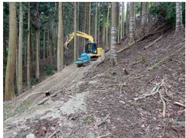
林道工事現場
