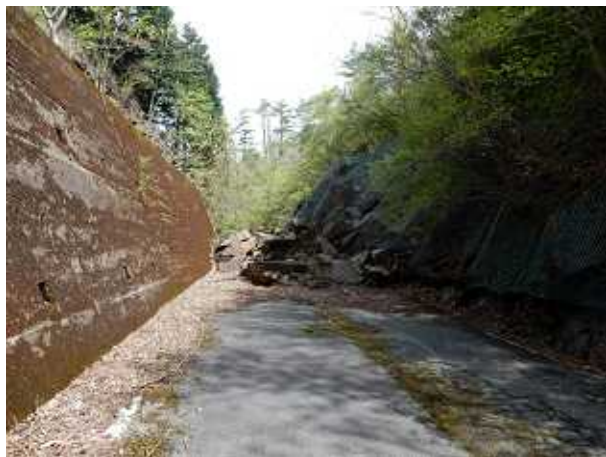
八代峠(土砂崩れ)
