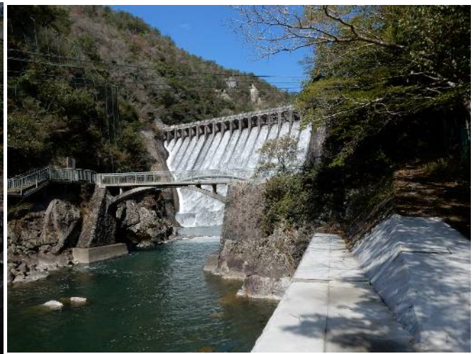
水路の対岸より
