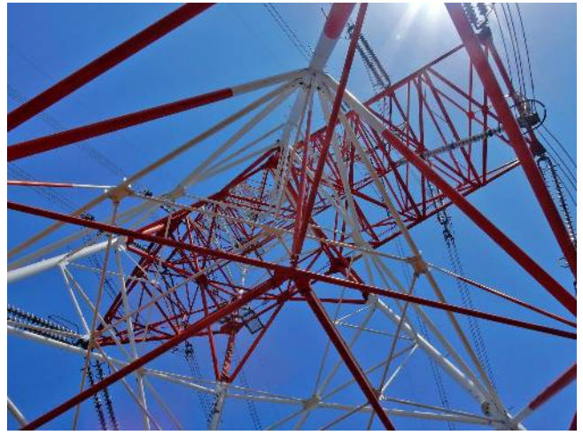
鉄塔を見上げる
